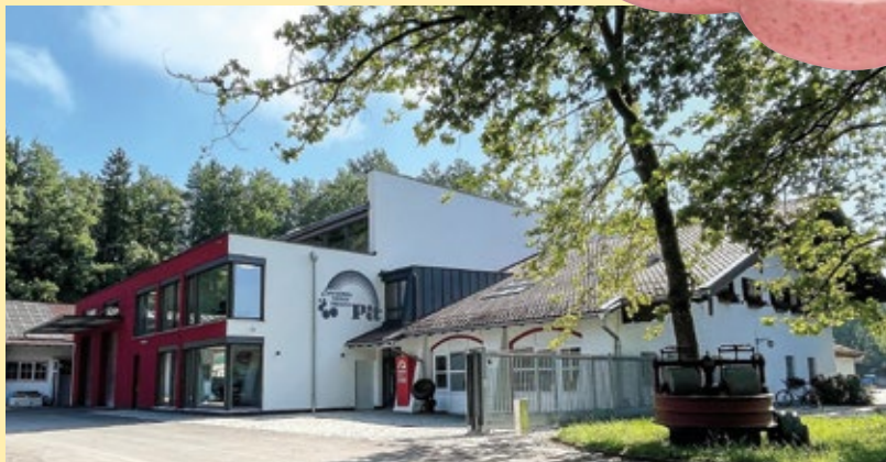
2020 Erweiterung der Büroräume durch einen modernen Neubau.
